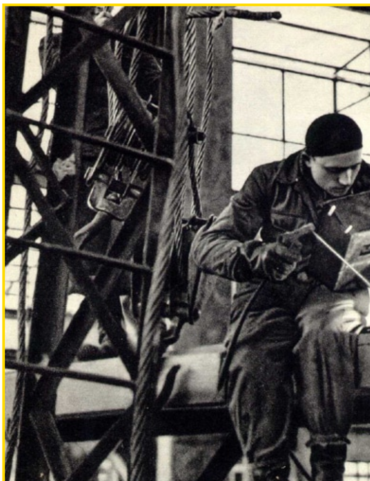
Spawanie stalowych konstrukcji
