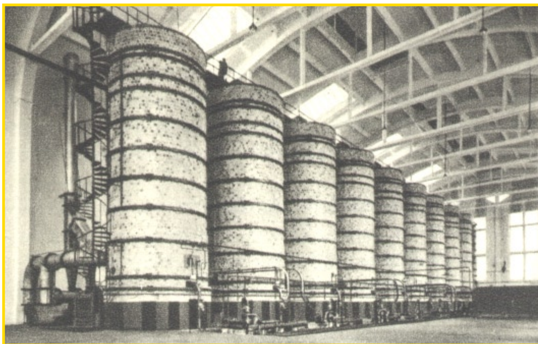
Wieże absorpcyjne systemu Mościckiego
