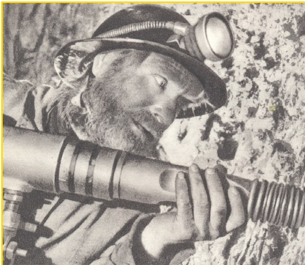
Górnik przy pracy. Wiercenie otworu strzałowego.
