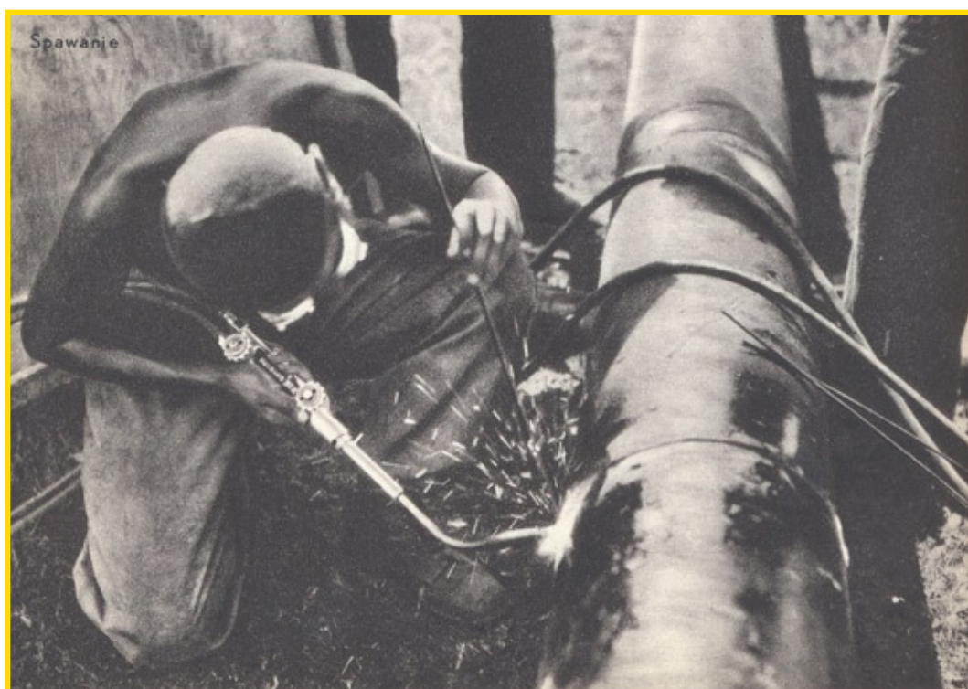
Spawanie rurociągu
