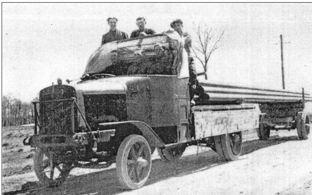
Budowa gazociągu z Daszawy do Lwowa (1929 r.). Transport rur
