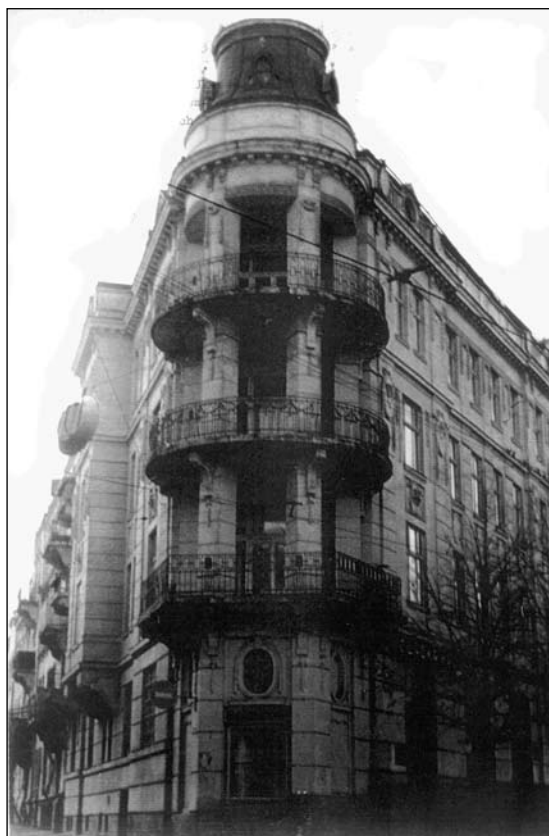
„Kuznia Nowych Myśli”. Budynek przy ul. Sapiehy 3 we Lwowie. Siedziba zarządu „Gazoliny” i spółki „Metan”, przeniesionej później do Warszawy i przekształconej w Chemiczny Instytut Badawczy.
